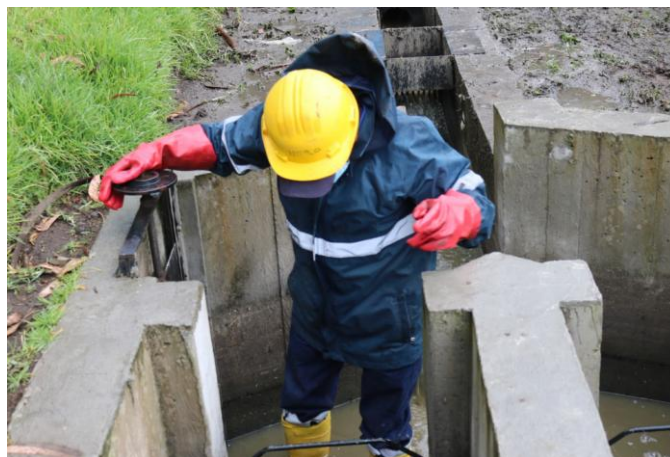
Figura 5. Trabajos de limpieza PTAR
